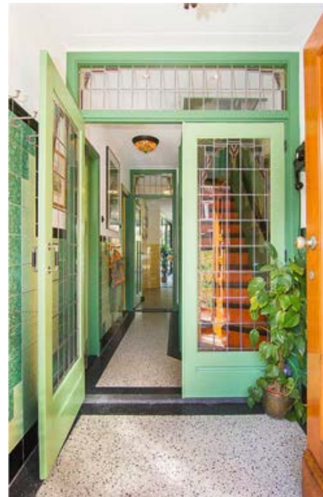
▲ Afbeelding 2 Bij deze hoekwoning uit de jaren 1930 is gelijk duidelijk dat het plaatsen van voorzetwanden ten koste gaat van tegellambriseringen uit de bouwtijd en dat voor een geïsoleerde betonvloer eerst de fraaie granitovloer gesloopt zou moeten worden.
