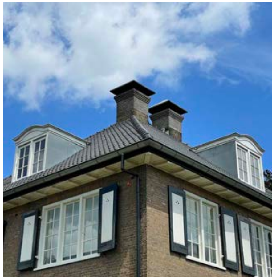
▲ Afbeelding XLVIII Dakkapellen met stolpramen en zijwangen met zink
