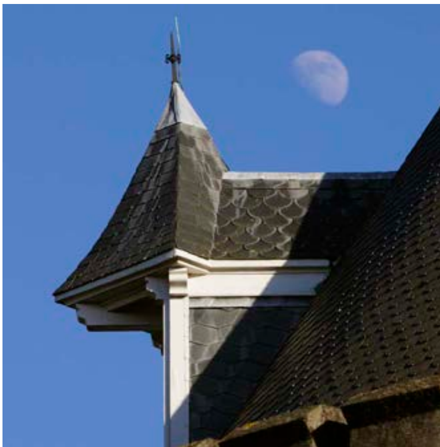
▲ Afbeelding XLVII Dakkapel met overstek en leibedekking
