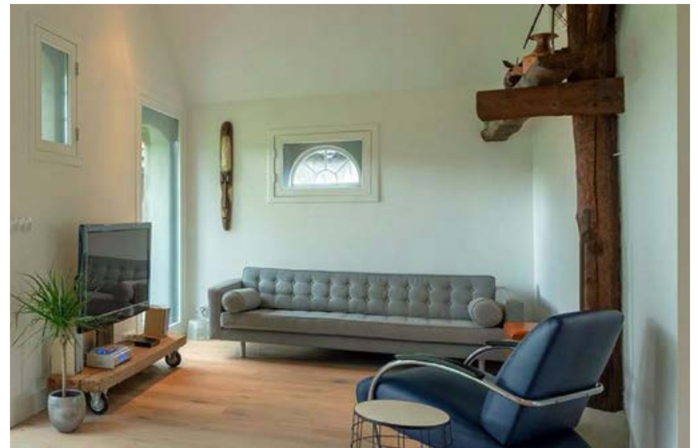
▲ Afbeelding XXXVIII In deze boerderij zijn alle achterzetramen opgenomen in de geïsoleerde voorzetwand.
