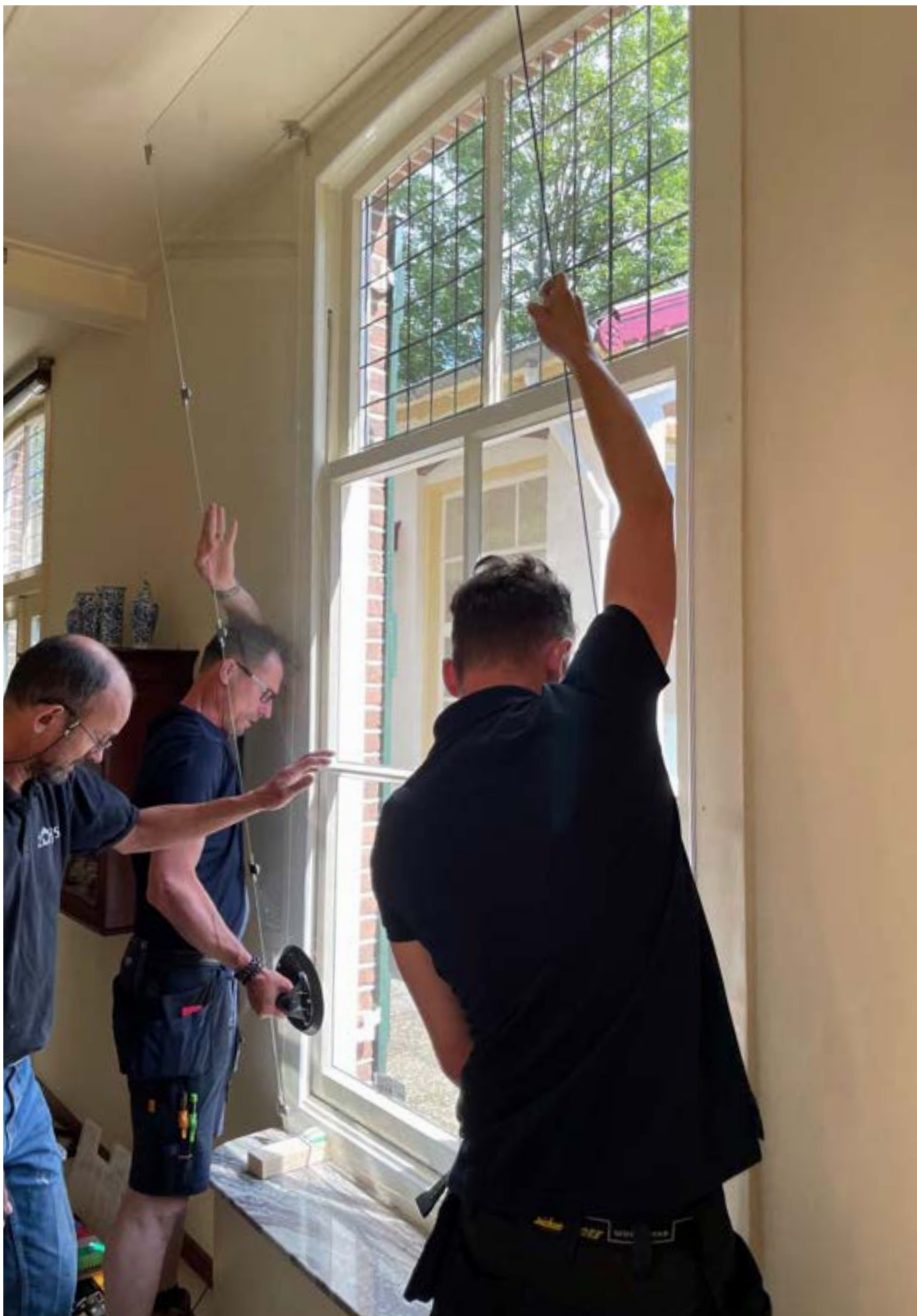
▲ Afbeelding XXXIV Achterzetgeglazing op een historisch valraam met geel kathedraalglas.
