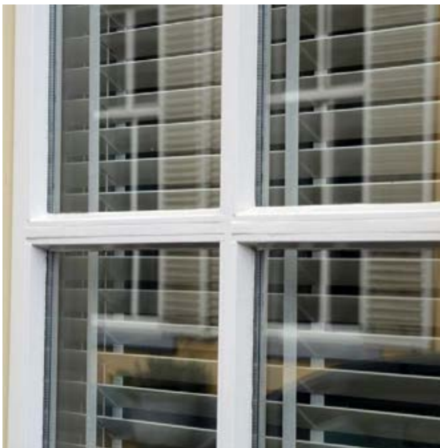
▲ Afbeelding XXX Roedenraam met dubbelglas en glaslatten, waardoor de roeden visueel veel dikker zijn geworden.
