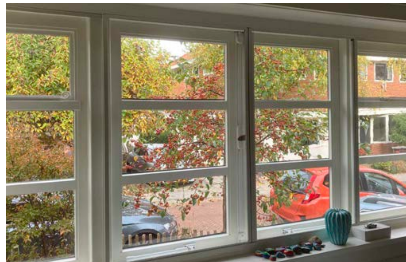
▼ Afbeelding XXXVI Een horizontaal schuivend achterzetraam met borstels als luchtdichting, achter een ladderraam uit de jaren 1920.
