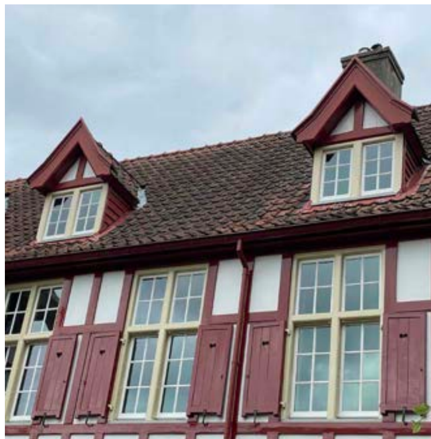
▲ Afbeelding LI Dakkapellen met pannen en houten zijwangen
