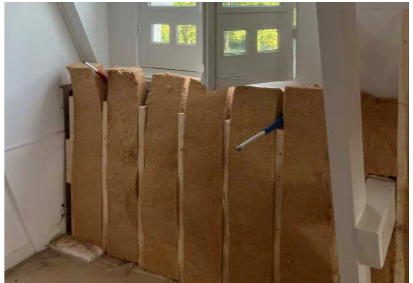
▲ Afbeelding 29 De leidingen van de centrale verwarming die hier uit de voorzetwand steken, zijn geïsoleerd. Dat is te zien aan de rode en blauwe mantel. Omdat de leidingen achter de isolatie langs lopen, dus aan de koude kant, verliezen ze zo minder warmte. Over de isolatie wordt hierna een dampremmende folie aangebracht. Omdat de leidingen van achter de voorzetwand komen, zullen deze dan wel lekken in de folie vormen. Een eventuele oplossing is een installatiespouw in de voorzetwand (zie detailblad 2.02). Daardoor wordt de wand wel een stukje dikker. Daar is niet altijd ruimte voor. Als er wel ruimte is, dan hoeven de cv-leidingen niet meer te worden geïsoleerd. De installatiespouw ligt namelijk aan de warme kant van de isolatie.
