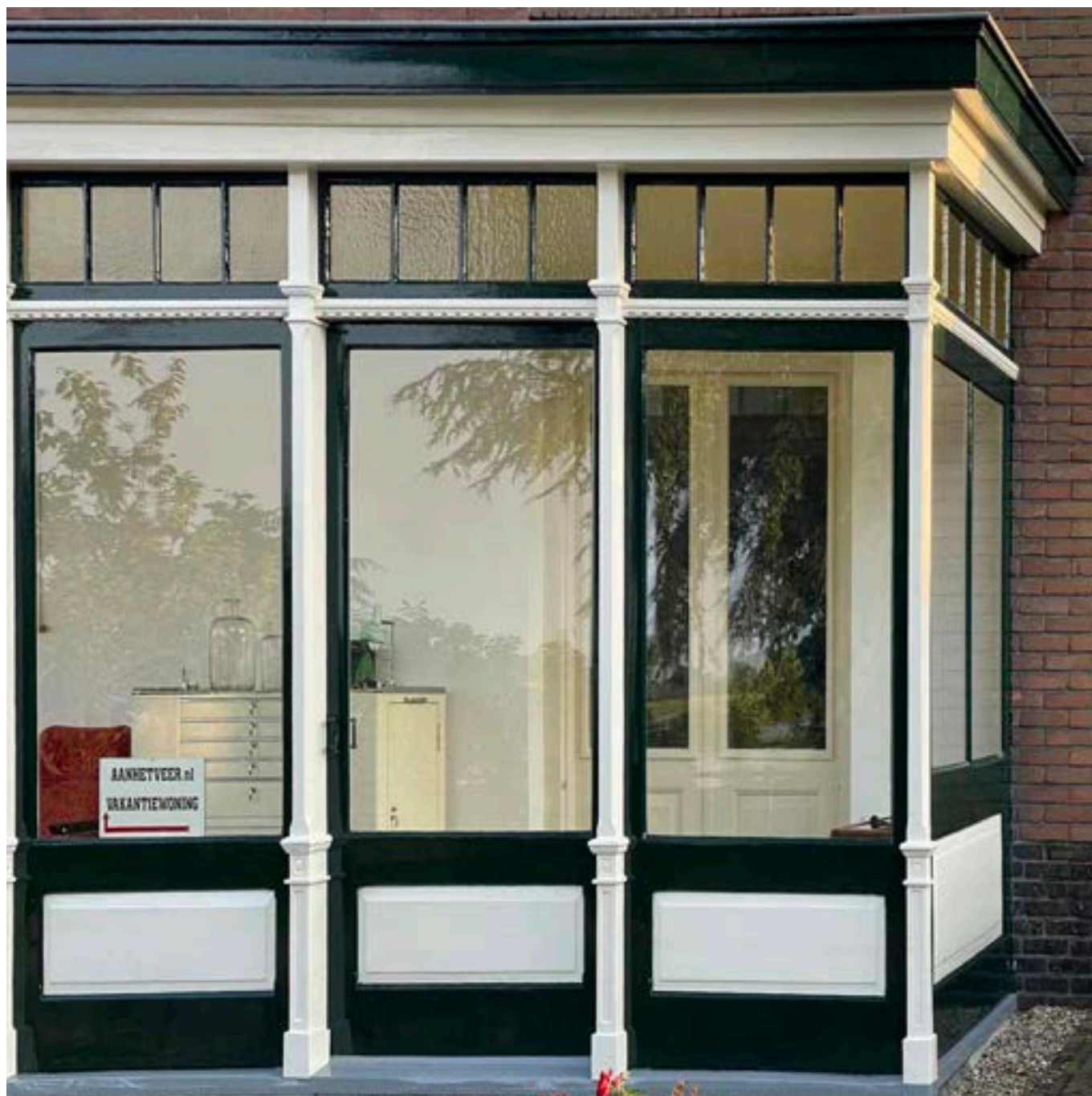
▲ Afbeelding 13 Historische serres kunnen in de winter beter worden afgesloten, zoals hier bij een pand in Dieren. Door het afsluiten ontstaat in de serre een tussenklimaat, waardoor vanuit de verwarmde woonkamer minder energie ontsnapt.
