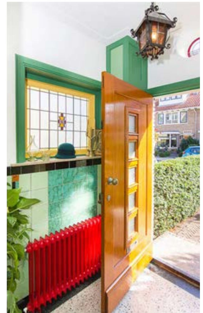
▲ Afbeelding 2 Bij deze hoekwoning uit de jaren 1930 is gelijk duidelijk dat het plaatsen van voorzetwanden ten koste gaat van tegellambriseringen uit de bouwtijd en dat voor een geïsoleerde betonvloer eerst de fraaie granitovloer gesloopt zou moeten worden.
