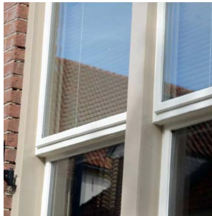
▲ Afbeelding XXXII Schuiframen met opdeklatten vanwege het plaatsen van isolatieglas. Door de latten schuift het onderraam niet meer omhoog en is het aanzicht gewijzigd.
