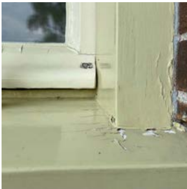
Om (meestal speciaal dun) isolatieglas te kunnen plaatsen, zullen de stopverf en het oude glas eerst verwijderd moeten worden. Als het nieuwe glas erin zit en is vastgezet met een stopverf vervangende kit moet er altijd geschilderd worden.
