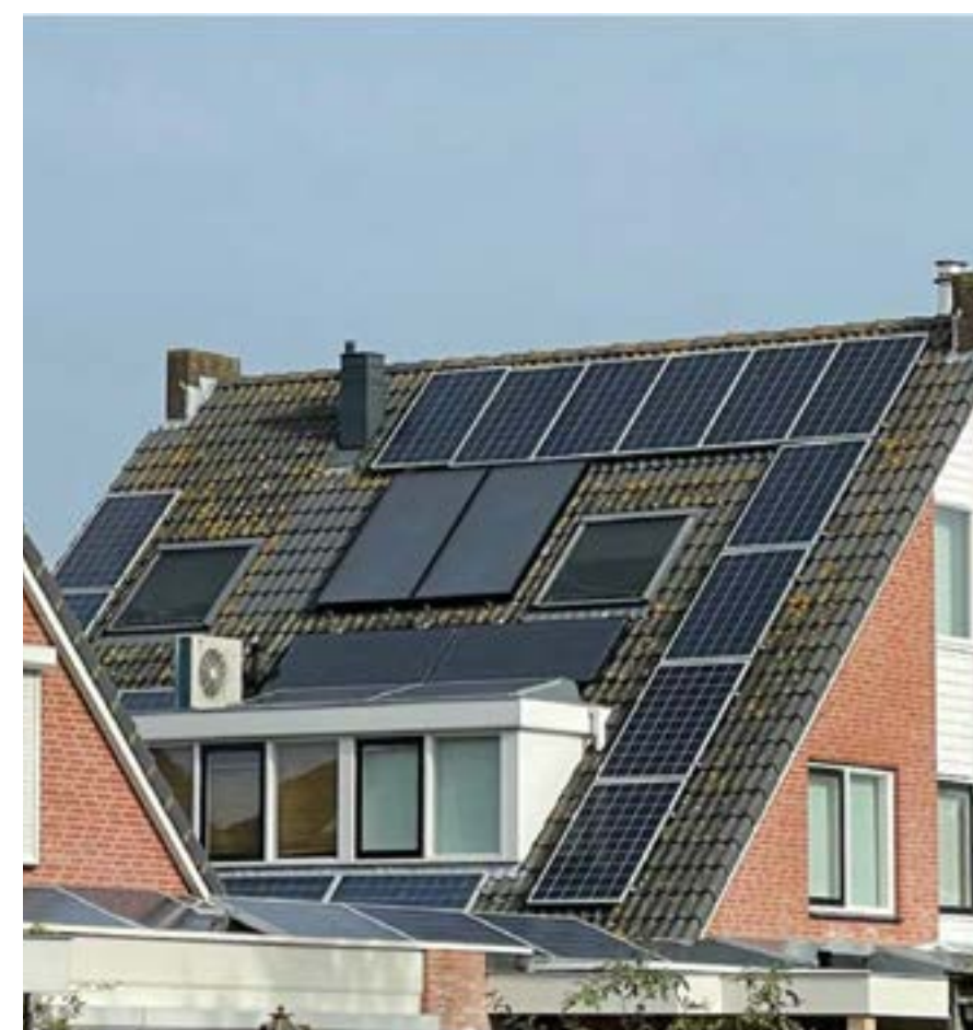
Afbeelding 27 Het gebruik van verschillende panelen, waaronder panelen met blank metalen kaders en rasters, en het puzzelen rondom bestaande voorzieningen in het dak om de opbrengst te maximaliseren, hebben bij dit huis een heel onrustig beeld opgeleverd. ▼
