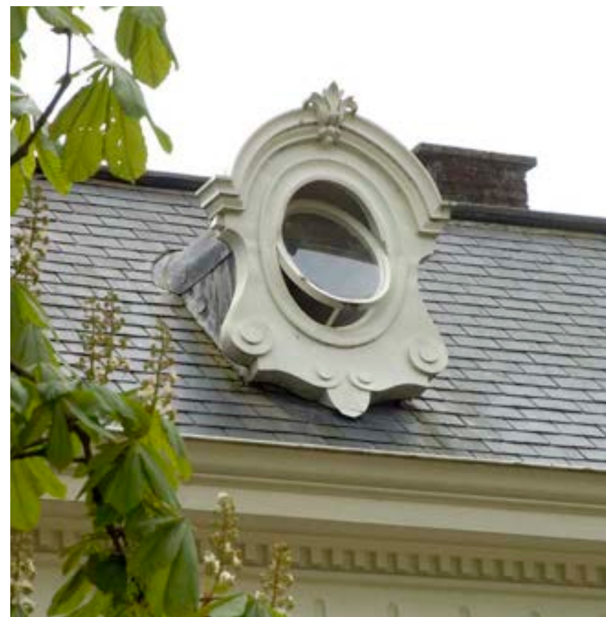
▲ Afbeelding LII Zinken dakkapel met een oeil-de-boeuf (rondlicht)
