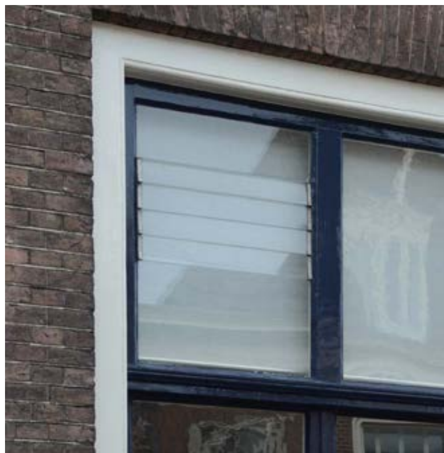
▲ Afbeelding XXI Glasjaloeziën in een bovenlicht
